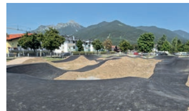
Die Arbeiten am neuen Pumptrack beim Schul- und Jugendzentrum Reutte schreiten voran – Foto Stand August. Foto: Stadtgemeinde Reutte
