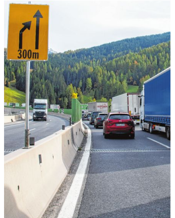
Vor und auf der Luegbrücke wird es eng. Die Einspurigkeitsphase als Regelbetrieb wird bis Ende 2027 dauern, Entlastungen inklusive. Foto: Falk
