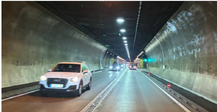
Die zweite Röhre am Lermooser Tunnel muss gebaut werden, weil sonst keine Genehmigung des Objektes mehr möglich wäre.
