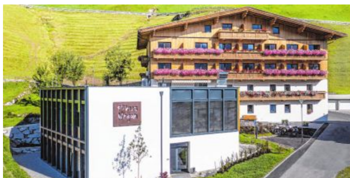
Das Hotel „Fokus“ (im Hintergrund) und das Forschungs- und Kommunikationszentrum des Vereins N’Cyan wurden als Leuchtturmprojekt vom Land gefördert.
