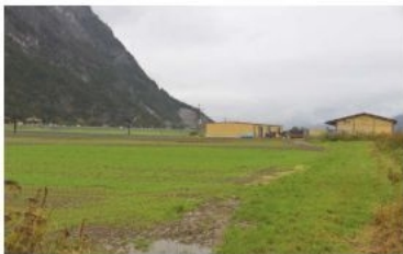
Auf einer landwirtschaftlichen Fläche vor den beiden Gebäuden wird das Biomasse-Heizwerk errichtet. Der Antrag auf Rückwidmung der Fläche wurde vom Gemeinderat abgelehnt.
