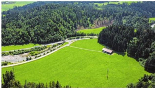
Rund um das denkmalgeschützte Anwesen „Unterbürg“ soll in St. Johann ein 7,5 Hektar großes Gewerbegebiet entstehen.
