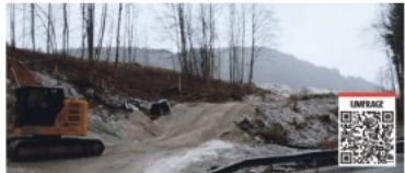
Die Bauarbeiten für den Geh- und Radweg sind gestartet. In der Kritik stehen allerdings die Kosten: rund 6 Millionen Euro für 900 Meter Weg. Foto: Nimpf
